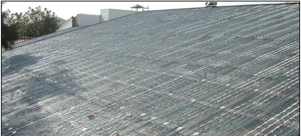
Ejecución con PLACNER® de cubiertas sobre estructura metálica
