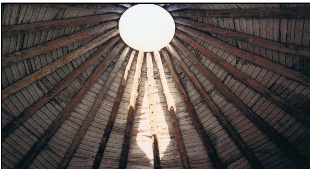
Cubierta troncocónica en construcción rústica – Estructura de madera.
