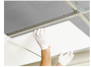
Las placas individualmente son fácilmente desmontables
